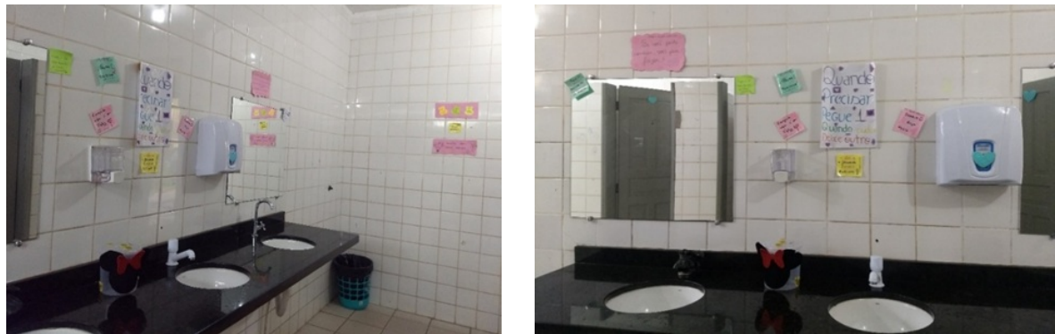
Figura 1 e 2 - Banheiro Feminino de uma Escola Pública de Ensino Médio – Boa Vista/RR
